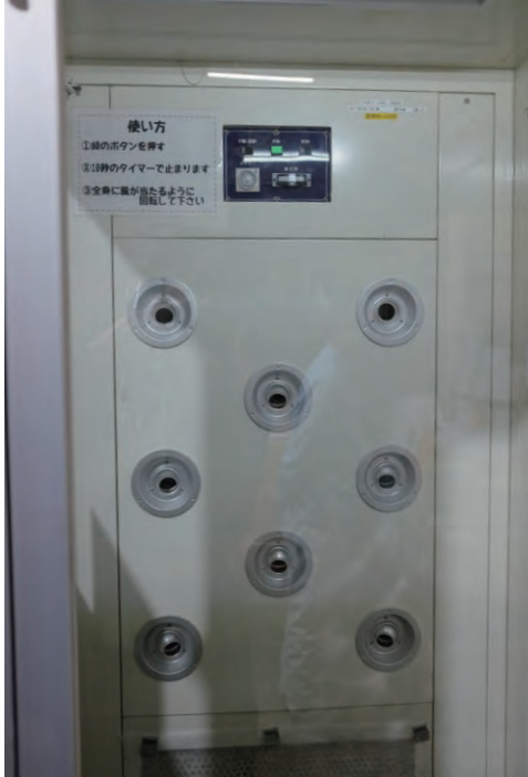
食品工場向け包材専業であるため、エアシャワーも設置している
